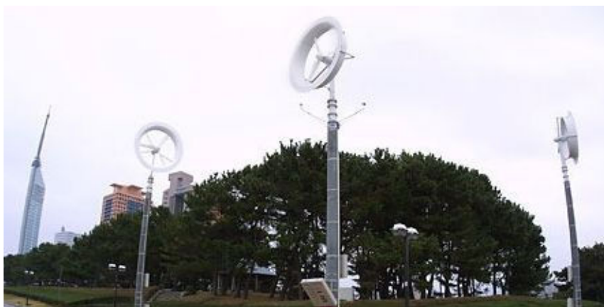
百道浜人工海岸に設置された3台の風力発電用の風車レンズ: 中央の配電盤モニターに風速と発電量が表示される仕組みになっているので、時々刻々変化する風速を体感し予測することを、毎朝犬の散歩の途中で行うようにしました(KY訓練)。
