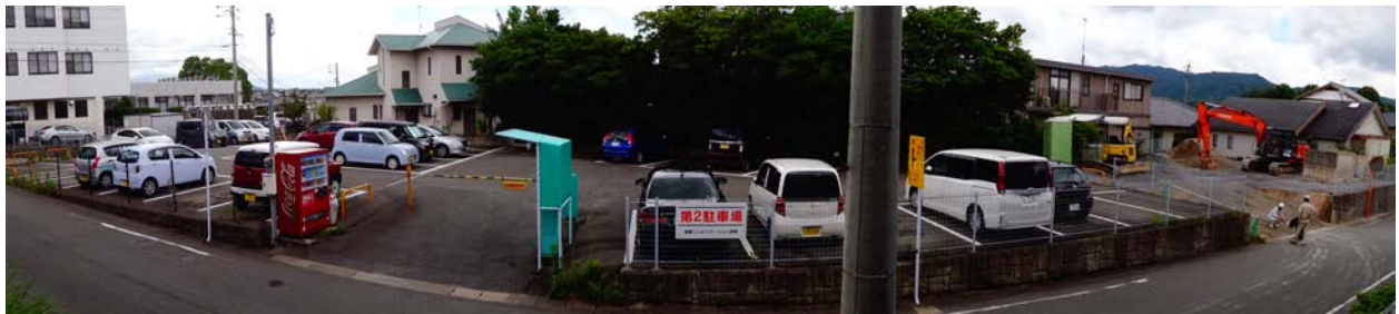
病院周辺の駐車場増設地 3
