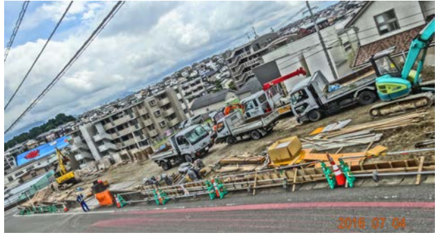
病院周辺の駐車場増設地 1
